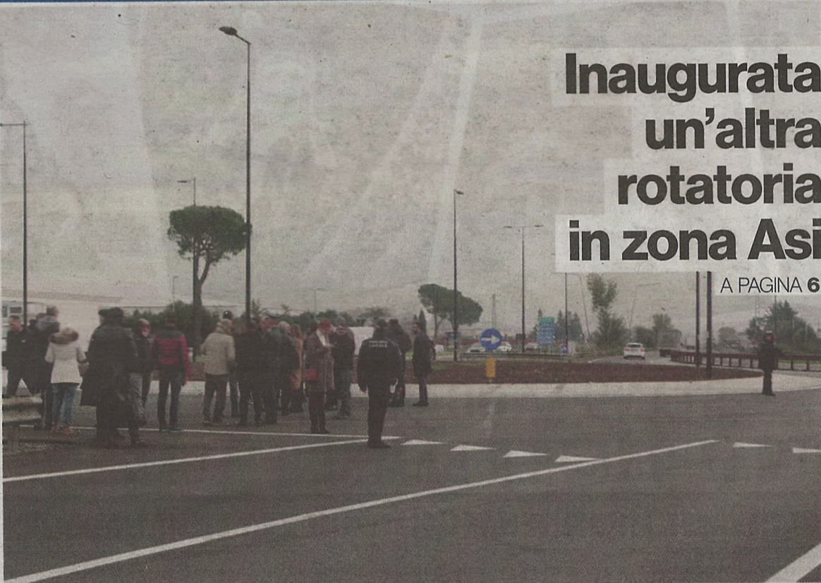
La nuova rotatoria Asi 7 nella zona industriale di Frosinone FOTO MASSIMO SCACCIA
