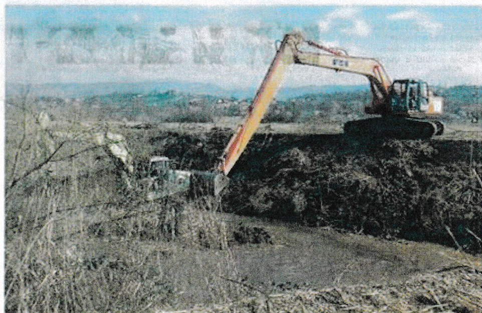
Uno dei numerosi interventi preventivi effettuati dal Consorzio di Bonifica sui numerosi fossi presenti nell'area di Anagni
